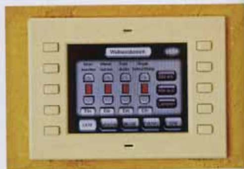
Das Herzstück des Lichtzaubers: Die Steuerung mit Bussytem. Komplette Beleuchtungsszenarien lassen sich vorprogrammieren.
