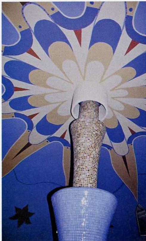
Der Mittelpfeiler aus Edelstahl wurde mit Lux-Elementen maßgeschneidert verkleidet.
