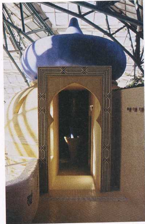
Die Lux-Hartschaum-träger-elemente sind mit verschiedenen Materialien verkleidet worden.
