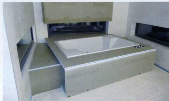
Gut zu erkennen: die diagonale Anordnung der Verkleidung. Die Plattenstärke von 50 mm erlaubt eine Nutzung des Wannenvorbaus als Bank.
