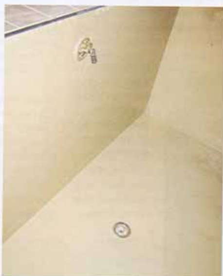
Das Ablaufsystem wurde nach der Montage eingedichtet und anschließend verflieset.
