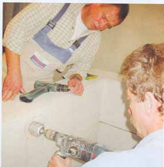
Die Mitarbeiter der Föbus-Haustechnik bauten auf der Baustelle das Ablaufsystem ein.
