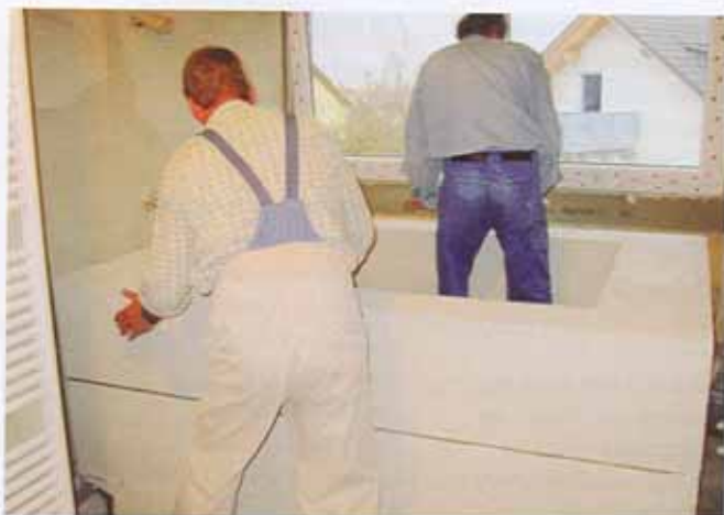
Im Badezimmer fügten die Monteure die maßgeschneiderten Hartschaum-Trägerelemente zu einer japanischen Wanne zusammen.
