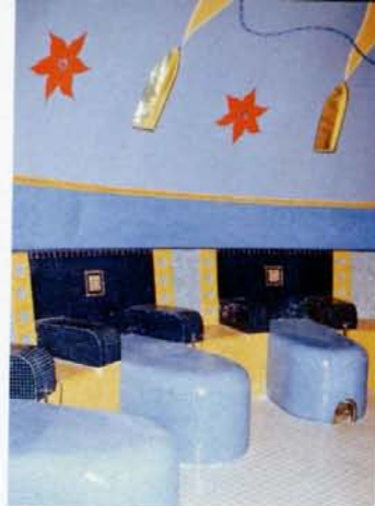
Im Bereich der „freien Formen“ ist ein hoher Vorfertigungsgrad sinnvoll
