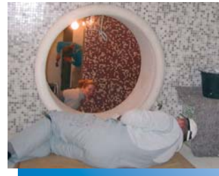
Das Bullauge während der Verfliesung mit Glasmosaik.
