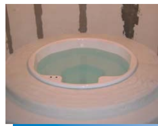
Der im Werk vorgefertigte Whirlpool inklusive Podest wird auf der Baustelle paßgenau aufgebaut.
