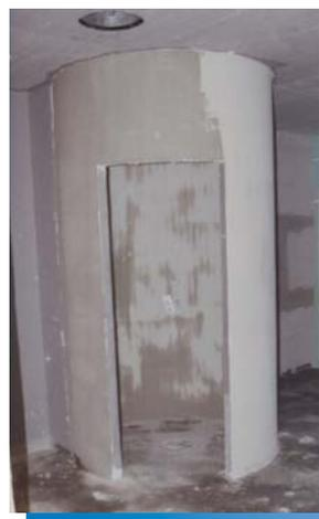
Die fliesenfertige Runddusche wurde aus Hartschaum-Trägerelementen der Produktlinie LUX ELEMENTS®-TUB erstellt.
