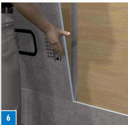
Dann die nächste ELEMENT-VK in das Kleberbett hineinschieben. Nach dem Ausrichten wiederum mit FIX-S 35 + geeigneter Schraube verschrauben.
