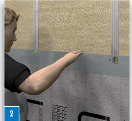
Die erste ELEMENT-VK wird quer zu den Profilen lot- und fluchtrecht ausgerichtet ...
