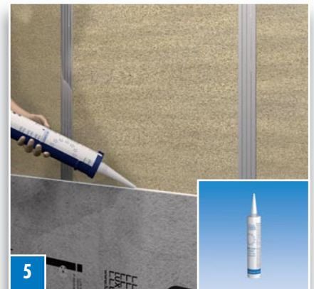
Die ELEMENT-VK Bauplatten werden untereinander mit COL-MK verklebt. Den Kleber dabei als ununterbrochenen Strang auf die Plattenkanten auftragen.
