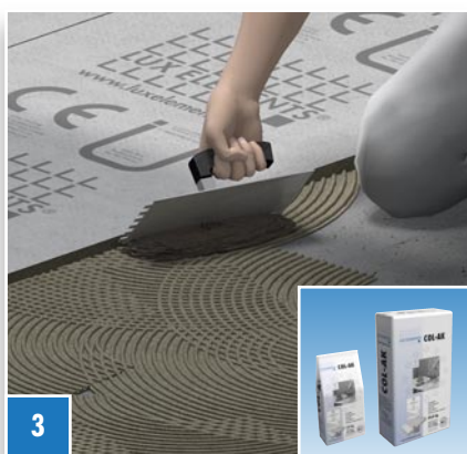
3 COL-AK mit einem Zahnpachtel (abhängig vom Untergrund, mind. 6 mm) gleichmäßig deckend auftragen.
