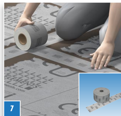
7 ... hierbei erfolgt die Verklebung des Dichtbandes DRY-DBV.
