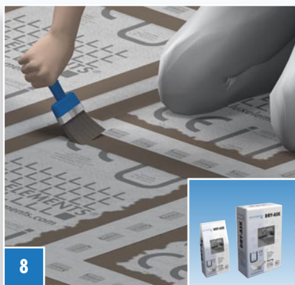
Im nächsten Schritt die Stöße mit DRY-ASK überstreichen.
