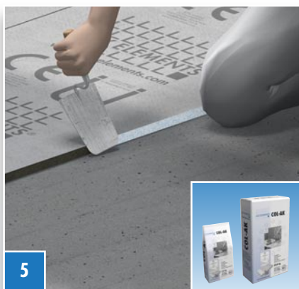
5 HINWEIS: Zur Verklebung der Kanten Ansetzkleber COL-AK mit Kellenspachtel auftragen.
