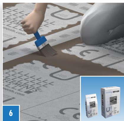
6 Zum Abdichten der Stöße den Dichtspachtel DRY-ASK mit Pinsel oder Spachtel auftragen ...
