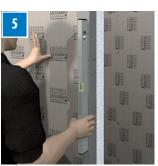
... und in die Führung der MONT-Profile ansetzen. Mit Richtlatte und Wasserwaage die lotrechte Ausrichtung der ELEMENT-EL Bauplatte überprüfen.
