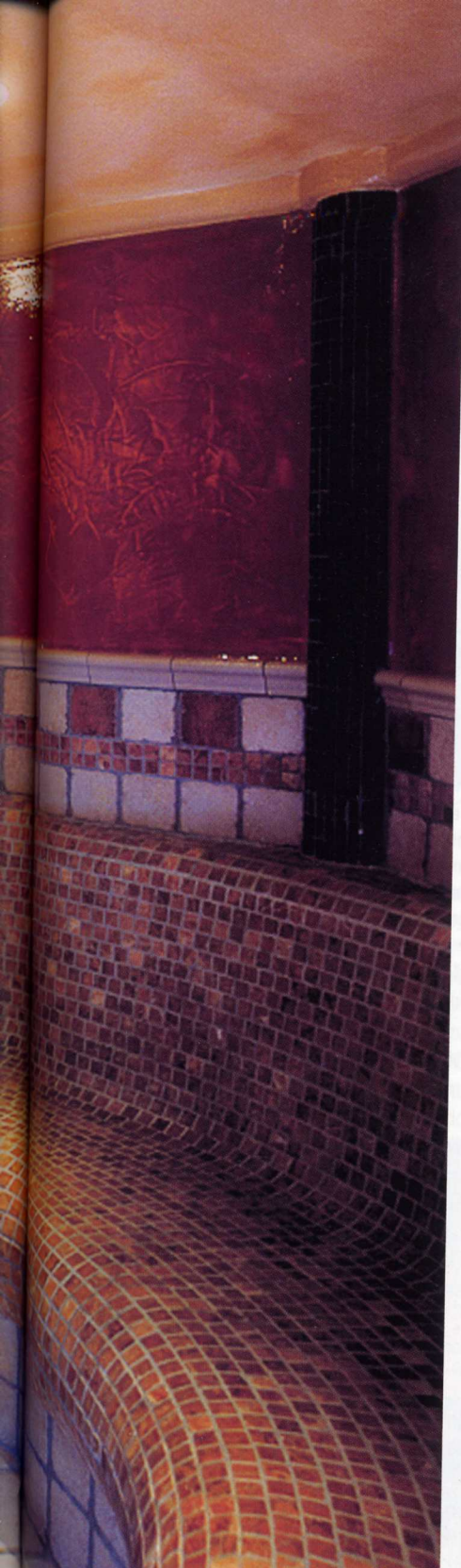
Silgmann-Dampfbad mit 3 m Durchmesser. Die Kabine wird aus Polystyrolelementen mit beidseitiger Glasfaserarmierung in freier Form erstellt. Und die Oberfläche ist mit „Appiani“-Mosaik belegt.
