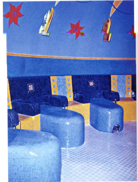
Gewerbliche Hamam-Anlage mit Dampfbad integriert. Die Kabinen wurden aus Hart-schaum-Trägerelementen von Lux-Elements gebaut, die als Baustoff für Wand-, Decken- und Bodenkonstruktionen dienen.
