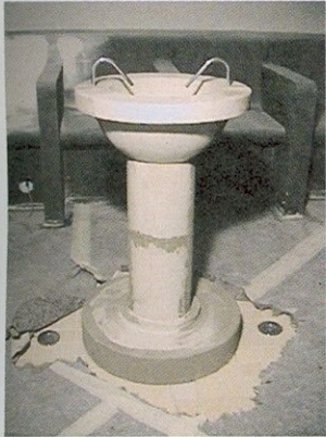
Der Trinkbrunnen im Caldarium im Rohbau.
