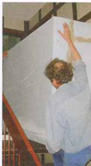
Auch ein enges Treppenhaus stellt kein Hindernis für den Transport dar. Zirkulieren ist trotzdem angesagt.
