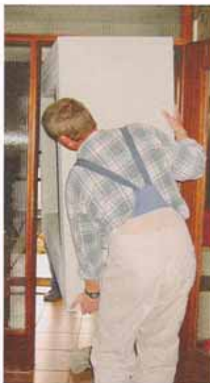
Die Einzelteile waren so vor-konfektioniert, dass auch der Transport durch schmale Türen möglich war.
