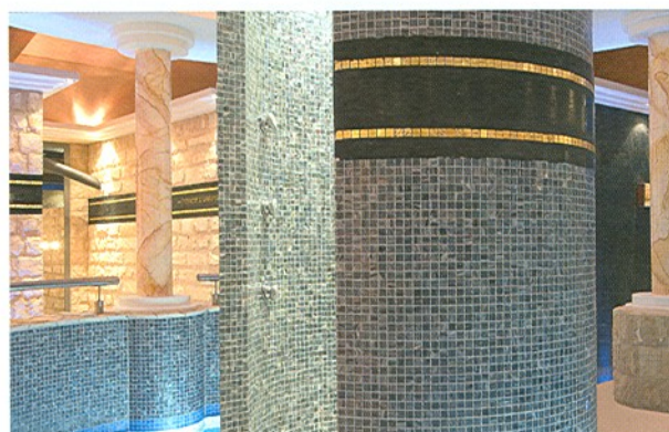
Spezielle Produktionstechniken ermöglichen geschwungene Wandflächen, die dann mit Mosaiken belegt wurden.
