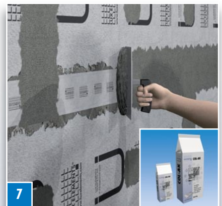
Im nächsten Schritt werden die armierten Elementstöße sowie die Köpfe der Befestigungssätze mit DRY-ASK überspachtelt. Die Fläche ist jetzt zur Aufnahme von Fliesen oder Putzen bereit. Weitere Anforderungen (z. B. Abdichtungen) sind gemäß nationaler Richtlinien zu berücksichtigen.
